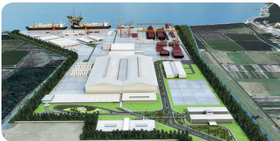
Estaleiro ENOR- Empreendimento de grande porte que não foi instalado em Alagoas
