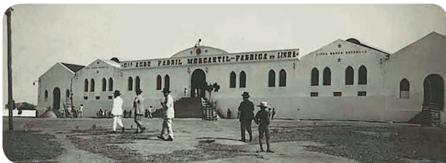
Fábrica da Pedra implantada por Delmiro Gouveia em 1914
