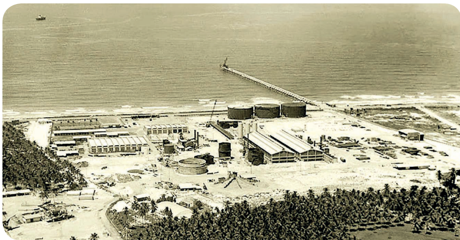
Obra de instalação da Salgema Indústrias Químicas S.A. / Maceió - Pontal da Barra - 1974
